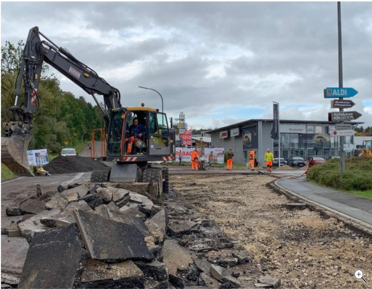
Sperrung in der Siemensstraße in Hilpoltstein, die in den nächsten Wochen umgebaut wird. Unter anderem entsteht ein neuer Fahrbahnteiler. (Foto: Tobias Tschapka)
